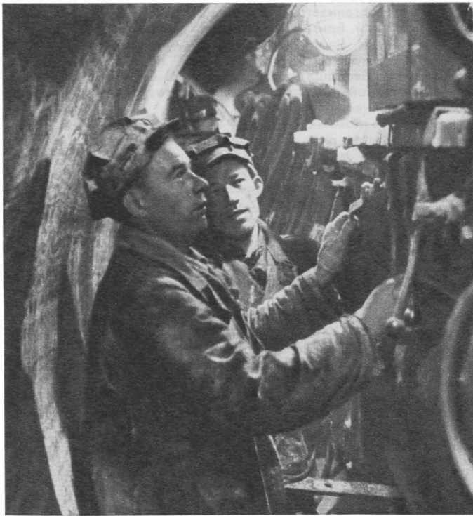
В шахте рудника Березниковского калийного комбината добывают сильвинит — удобрение для колхозных полей. День и ночь работают проходческие комбайны. Одним из таких агрегатов управляют Н. П. Межуев (слева) и Д. Ф. Минеев.
