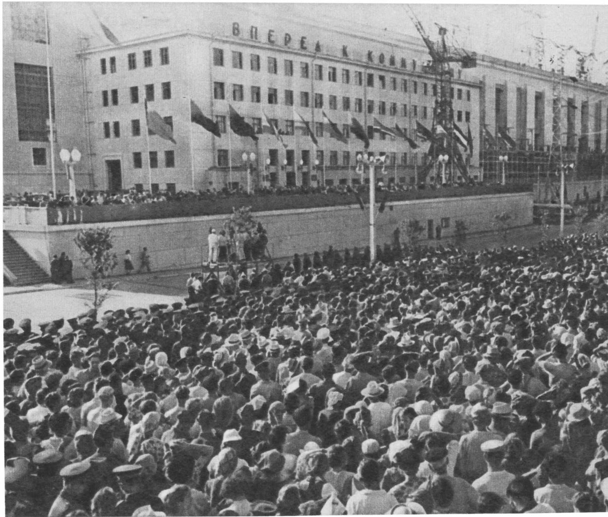
Митинг строителей Волжской гидроэлектростанции имени В. И. Ленина.
