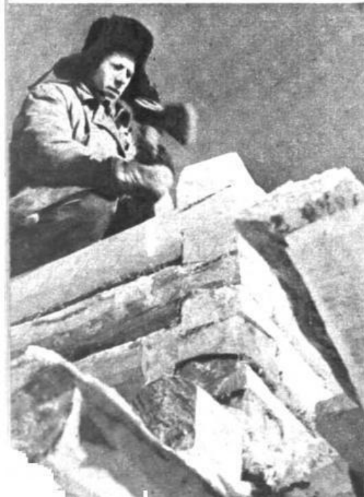
Плотник Виктор Шульга работает на строительстве 16-квартирного дома в Мирном.
