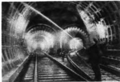
В тоннеле у станции «Технологический институт-2». Фото С. Григорьяна.
