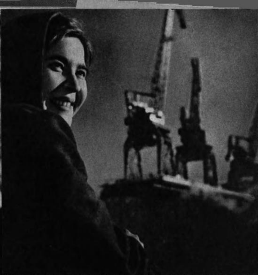
Лидия Абакумова — бетонщица. Фото М. АЛЬПЕРТА. Из серии «Братская ГЭС».
