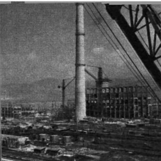
Кремиковцы. Строительство металлургического комбината. Фото Д. Кацева.
