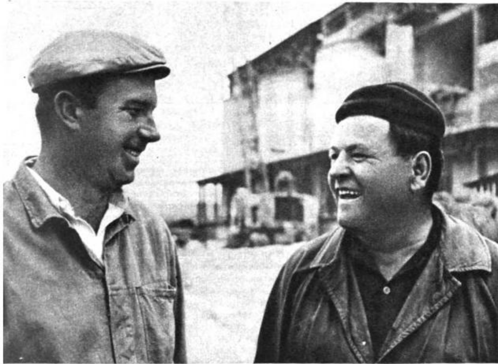
Третий год работают на строительстве цементного завода плотники из Праги Рихард Шебанек и Ян Чурей.
