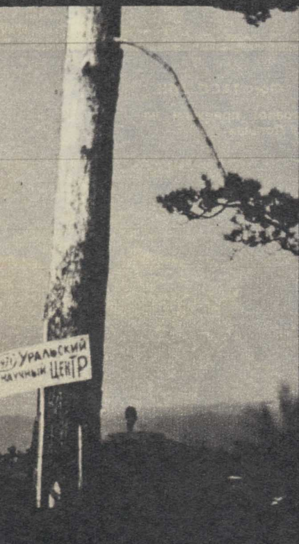
Так начиналось строительство Свердловского академгородка — с дощечки на сосне.
