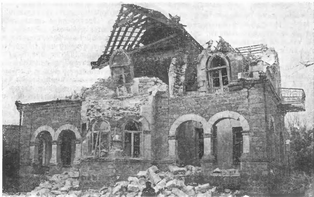
Фиг. 1. Балаклава. Дача Лишиной на болотистом аллювиальном грунте, разрушенная землетрясением 12/IX 1927 г.
