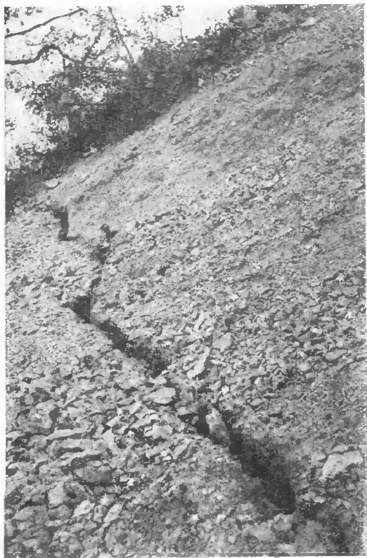
Фиг. 6. Байдарские ворота. Трещины в осыпи кальцитового месторождения над скрытым сбросом.
