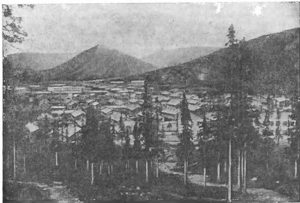
Фиг. 8. Стройка г. Кировска. Район 20-го километра.
