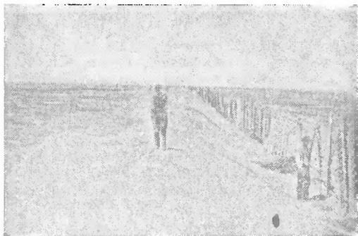
Фиг. 8. Линейная защита из снеговых решётчатых щитов на Ашхабадской железной дороге, 1936.
