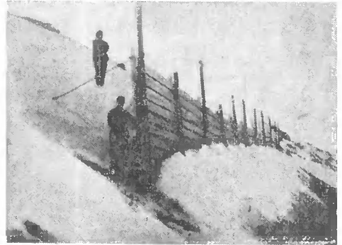
Фиг. 3. Укрепление лавиноопасных склонов горы.
