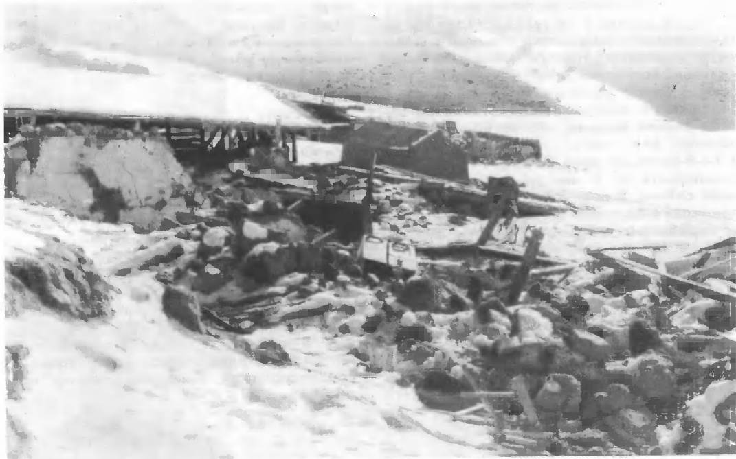
Разрушение построек в эпицентральной зоне землетрясения (8 баллов).
