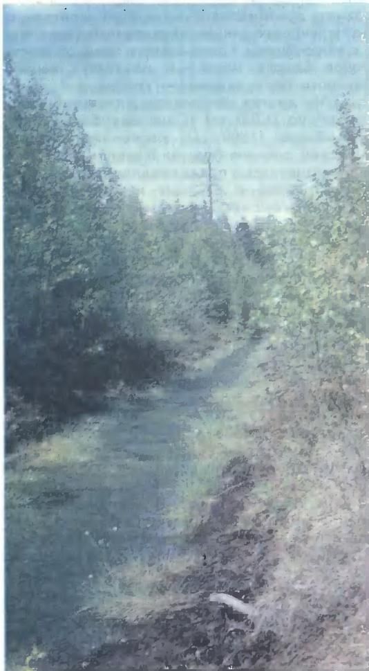
Зарастающая магистральная канава — одна из многих, проложенных на болотных массивах Карелии. Осушение с помощью таких канав сказывается только в непосредственной близости, и там хорошо растут деревья, вдали от канав результаты осушения почти незаметны. Без надлежащего ухода даже широкие канавы начинают зарастать, и мелиорация сводится на нет.
