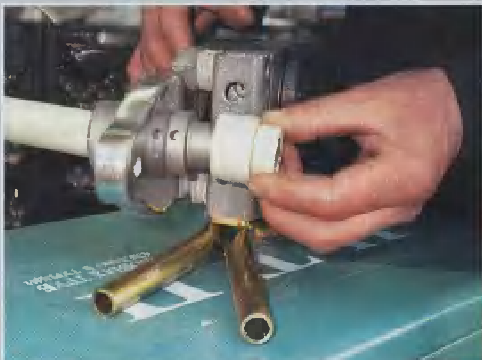
Перед стыковой трубой из полипропилена необходимо нагреть специальным паяльником
