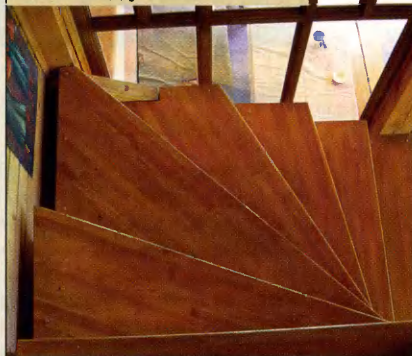
Лестница поворачивает под углом 90°
