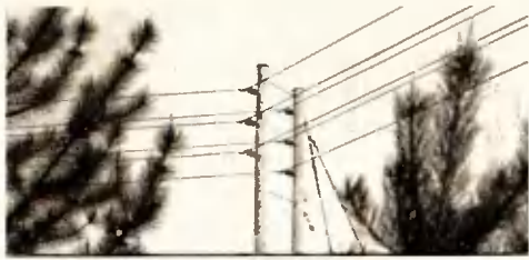
Рис. 13.38. ВЛЗ напряжением 6...10 кВ — двухцепная угловая опора
