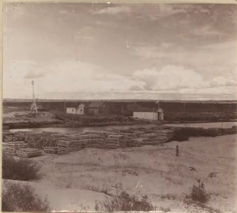
Спасательная станция на Онежском озере
