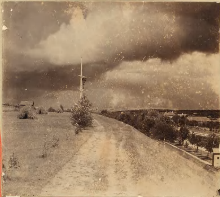
Около шлюза мачта со знаками, указывающими глубину фарватера в р. Славянке.
