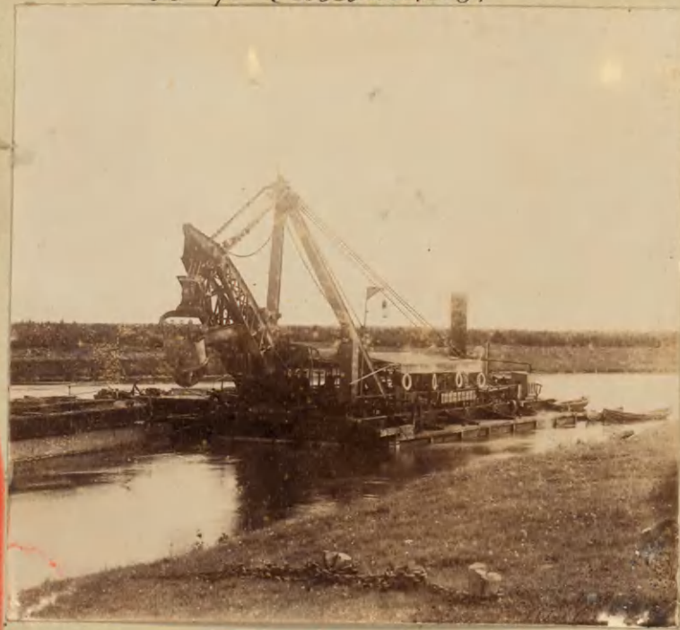
Компьютерная машина одночерпакового типа "Сви́рская 2 ая "
