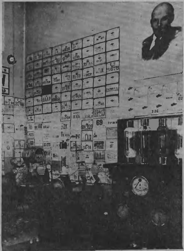
Радиостанция JСКВ-3. Справа — выпрямитель, слева — передатчик, внизу — возбуждатель.
