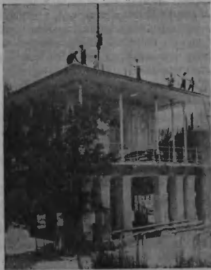
В г. Коканде состоялось открытие клуба Союза Строителей. На снимке: Установка радио-мачты на крыше библиотеки клуба.
