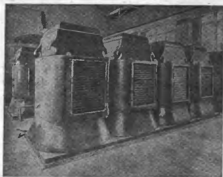
Трансформаторы на гидроэлектр. на Ниагаре
