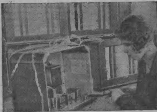
2 Сборка динамиков на радиотелефонном заводе в Горьком
