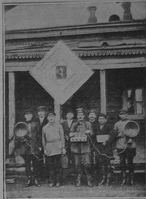
Показательная радиопередвижка с рамочной антенной, изготовленная электромехаником т. Эберлином. Ст. Почеп, Брянской губ.
