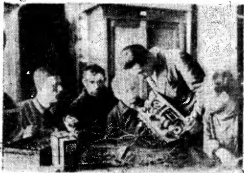
Ремонтируют установку для подшефного колхоза
