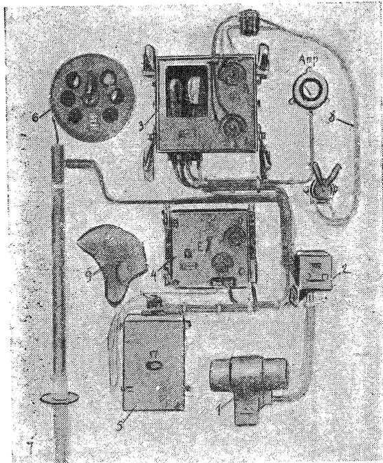
Рис. 2. Радиостанция типа 378<sup>Г</sup> фирмы «Telefunken» малой мощности с питанием от умформера и аккумулятора. 1—умформер, 2—телеграфный ключ и переключатель родов передачи, 3—радиопередатчик, 4—радиоприемник, 5—распределит. щит, 6—антенная лебедка, 7—изоляция антенная труба, 8—буоденовское управл. на расстоянии. 9—шлем с телефонами, 10—антенный амперметр
