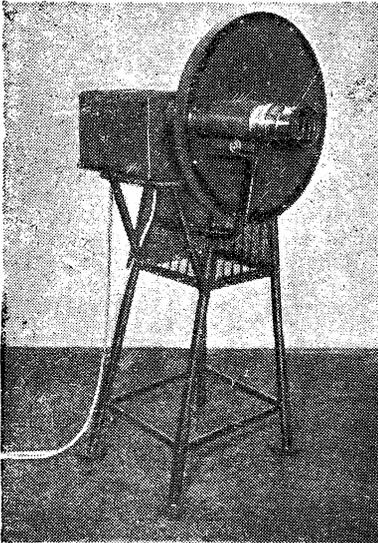
Рис. 2. Общий вид передатчика прямого видения
