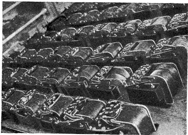
Завод им. «Радиофронта» (бывш. СЭФЗ). На снимке — готовые трансформаторы перед контрольной проверкой
