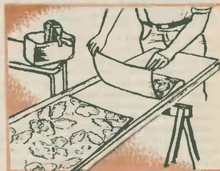
Рис. 17. Если работает один человек — можно сделать запас, складывая намазанные полотнища клеевыми сторонами.
