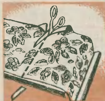
Рис. 12. По первому полотнищу обоев равняют остальные — поэтому его вертикальность лучше проверить отвесом.
