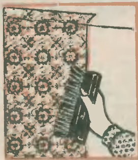
Рис. 21. Разравнивание и прикатывание обоев щеткой.
