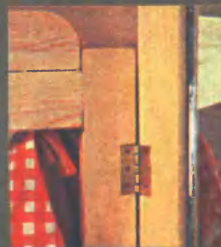
Дверка подвешена на двух петлях, врезанных заподлицо, чтобы в закрытом положении она вплотную прилегала к вешалке.
