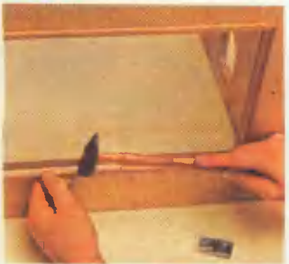
7 Такие же штапики применяют и для крепления стекол в фальцах оконного проема.
