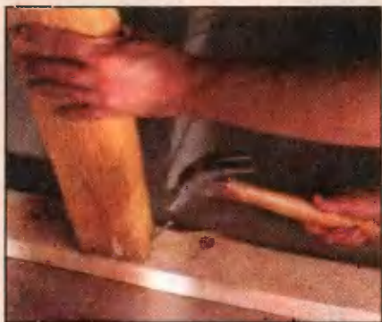
Стойки крепят к нижней обвязке наклонно вбиваемыми гвоздями.
