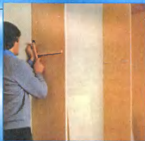
8 Полка с выдвигаемыми скалками держится на опорных планках, к которым ее дополнительно привинчивают. Теперь нужно установить полкодержатели во втулки.
