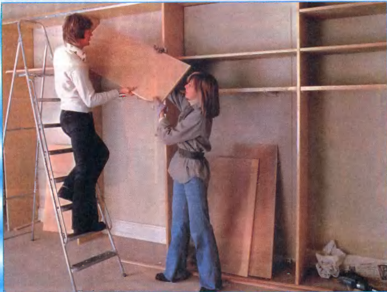
13 О точности работы можно судить по тому, хорошо ли подходят полки. Левую вертикальную стенку дополнительно крепят прибиваемой к полу планкой.
