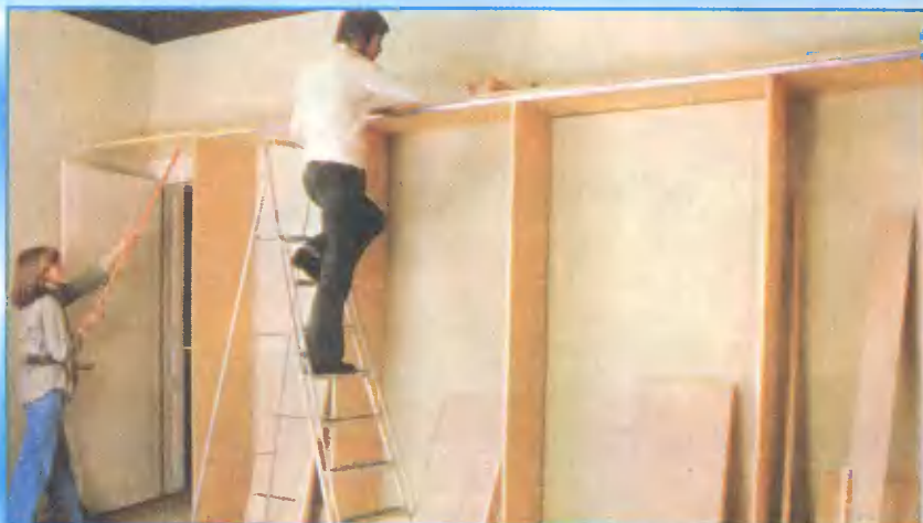
7 Каркас собран. Верхняя замыкающая доска образует козырек над раздвижными дверьми.
