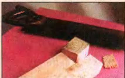
Вырезы на торцах стропил G надо сделать так, чтобы уклон крыши составил примерно 13–14°.
