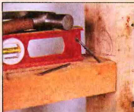
Подоконный K и дверной N1 ригели тщательно выставляют по уровню и крепят гвоздями.
