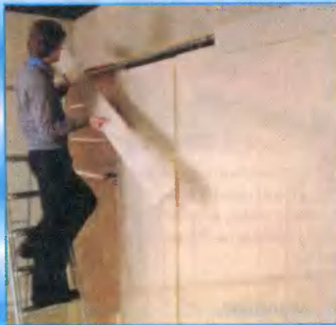
15 Шурупами к верхнему горизонтальному щиту крепят карнизную доску, закрывающую фурнитуру и направляющие раздвижных дверей. Карнизная доска завершает декоративное оформление шкафа.
