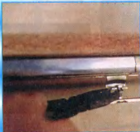
14 Снабженную фурнитурой дверь винтом крепят к «каретке», перемещающейся по направляющей. Конструкция позволяет выверить положение двери по вертикали и высоте.
