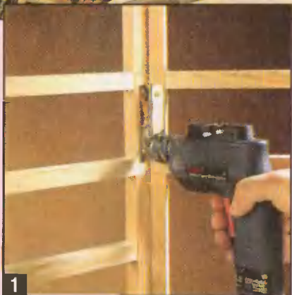
1 Каждую раму стеллажа соединяем с соседней тремя петлями.
