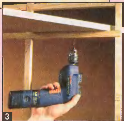
3 Уложенные по месту полки соединяем с несущими поперечинами шурупами.
