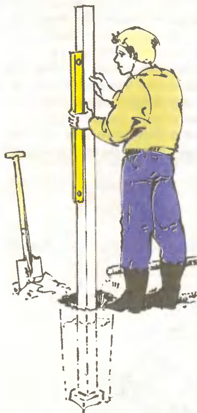
Рис. 2. Закапывая столб, его удерживают строго в вертикальном положении.
