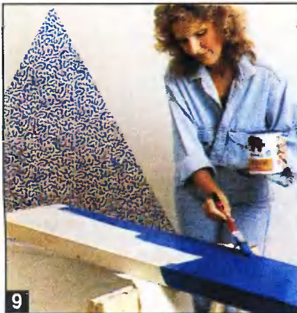
9 При окрашивании полки кистью краску следует равномерно растушевывать по поверхности, чтобы не было видно четких границ между мазками.
