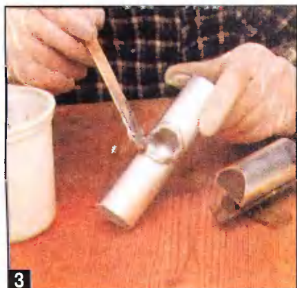
3 Клей наносят шпателем на обе склеиваемые детали.
