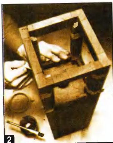
После установки полки вклеивают угловые фигурные штапики.
