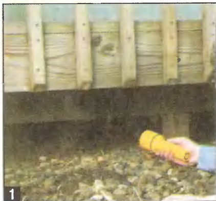
1 Осмотр нижней части настила. Особое внимание обращают на соприкасающиеся поверхности и концы балок.
