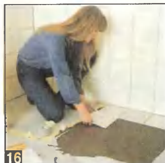
16 Плитки пола кладут на быстро-схватывающийся клеевой раствор, по которому можно ходить уже через три часа.
