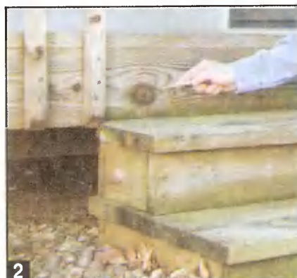
2 Проверка состояния поврежденной поверхности и сучков. Места, где были выпавшие сучки, заполняют клеем на основе эпоксидной смолы.
