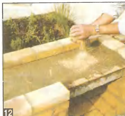
После укладки плитки надо затереть жидким раствором или специальным клеем-герметиком швы. Для удаления остатков раствора с поверхности плитки припудрите их опилками и протрите влажной тряпкой.
