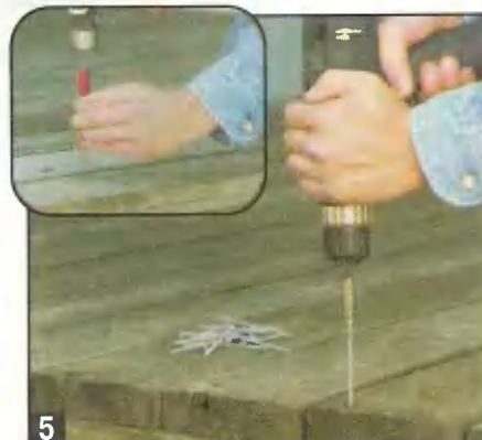
5 По периметру площадки вкручивают 75-мм саморезы. В других местах гвозди прибивают.
