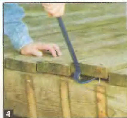
4 Приподнимая и опуская доски, освобождают шляпки гвоздей. Сгнившие доски меняют на новые.
