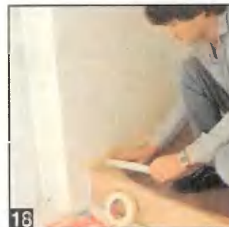
18 В обклеенные лентой швы вы-давливают сантехнический герметик.
