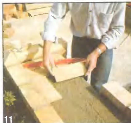
Кафель укладывают, контролируя горизонтальность по уровню. Размеры плиток и схема укладки должны быть такими, чтобы не резать лишних плиток.
