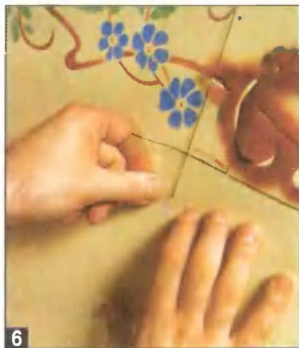
При точной выверке приводных меток относительно нанесенных мелом линий можно легко нанести и многоцветные узоры.
