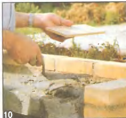
Выждав несколько дней после отливки полки, на ее поверхность можно укладывать кафельную плитку на слой раствора.
