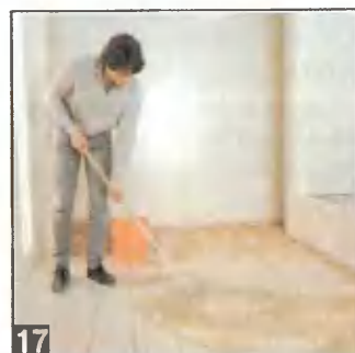
17 Можно также заполнить швы на полу затирочным составом под цвет плитки.
