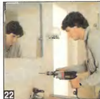
22 При сверлении плитки соблю-дайте осторожность, не нажи-майте на дрель слишком сильно.
