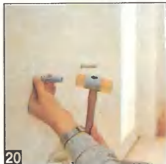
20 Чтобы не разбить плитку при вбивании дюбеля под умывальник, пользуйтесь пластмассовым молотком.
