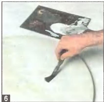
На окрашенную в белый фоновый цвет поверхность с помощью кисти, губки или тампона наносят тонированное (сероватое или серовато-желтое) «масло для живописи». Ближе всего к естественной получается поверхность, окрашенная почти сухим тампоном.
