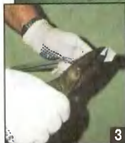
Резка ножницами по металлу потолочных панелей, П-образного профиля и окантовочного уголка.
