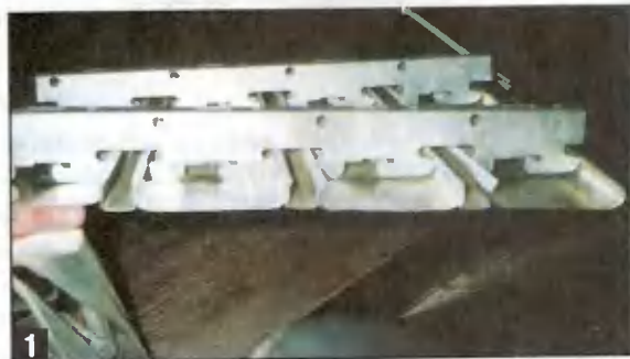
Стример имеет сложный профиль, в который, слегка надавив, вставляют потолочные панели.
