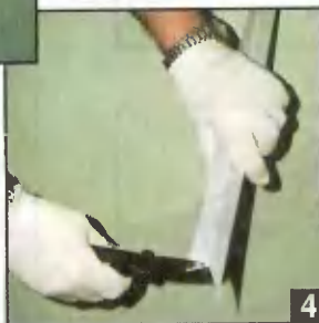
Резка ножницами по металлу потолочных панелей, П-образного профиля и окантовочного уголка.
