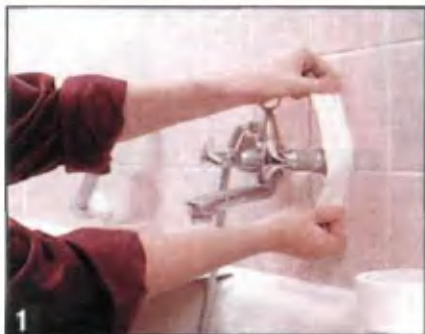
1 Сантехническую арматуру и поверхности вокруг нее тщательно обклеивают защитной клейкой лентой.
