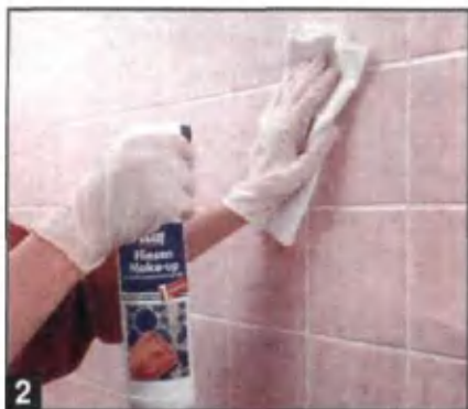
2 Подлежащие обновлению поверхности опрыскивают чистящим средством и протирают тряпкой.
