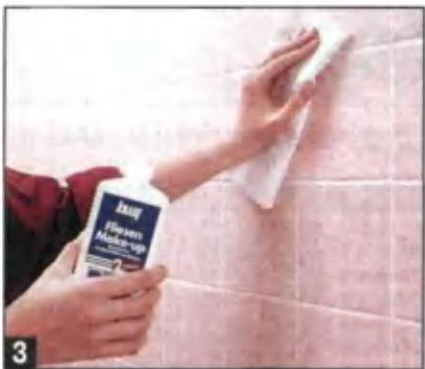
3 Спустя примерно 20 мин на поверхность куском ткани наносят тонким слоем грунтовку, продолжительность сушки которой составляет около 30 мин.
