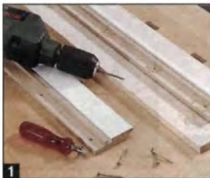
В несущих профилях с шагом 20-30 см сверлят отверстия. Первым крепят на дюбелях и шурупах нижний профиль, располагая его у плинтуса.
