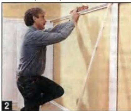
Затем крепят верхний профиль, используя две панели в качестве распорок. Положение профиля проверяют уровнем.
