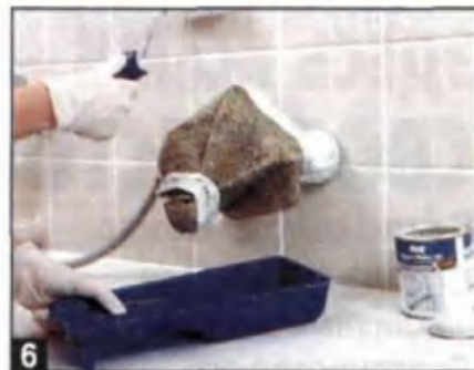
6 Нанесение защитного покрытия. В труднодоступных местах покрытие наносят кистью, на всю остальную поверхность — валиком. Продолжительность сушки этого покрытия — около 12 часов.
