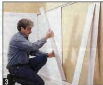
Далее одну за другой монтируют панели, просто вставляя их между профилями.
