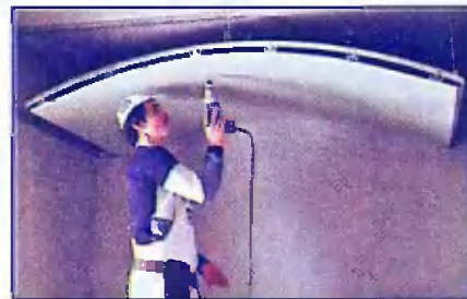
При больших радиусах изгиба гипсокартон перед креплением к каркасу можно слегка увлажнить.
