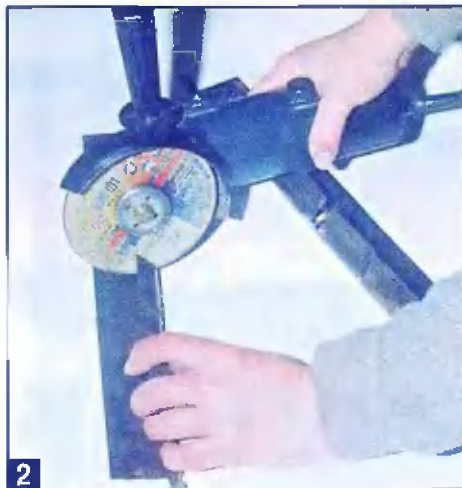
2 Изготовление из металлических уголков деталей крепления сетки с использованием угловой шлифовальной машинки.
