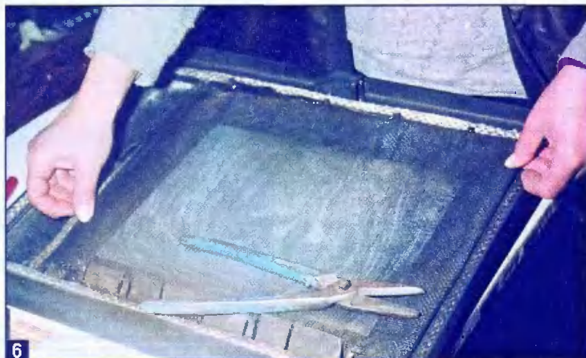
6 Крепление металлической сетки в дверце печи.
