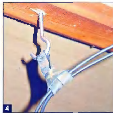
4 С помощью свернутого так резинового колечка, вырезанного из велосипедной камеры, можно надежно закрепить временную проводку к люстре.
