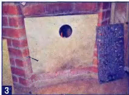
3 Для подсоединения печи к камину служит щит из 10-мм фанеры с круглым отверстием \varnothing 100 мм.
