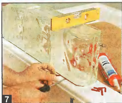
Рис. 1. Монтаж стенки душевой кабины из стеклоблоков.
