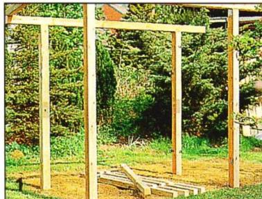
Основа конструкции открытого хозблока — две рамы, каждая из которых состоит из двух стоек, соединенных балкой. Расстояние между стойками в раме зависит от выбранных размеров хозблока.
