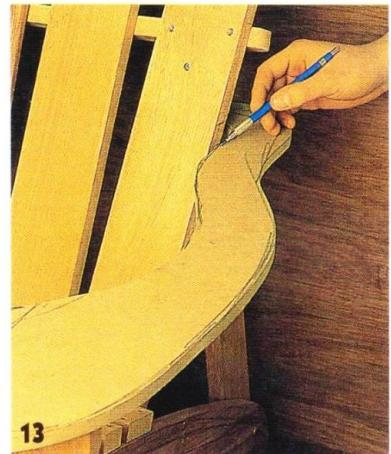
фигурных подлокотников можно изготовить из плиты MDF или из фанеры (**фото 13**). Нужное (горизонтальное) положение подлокотников определяют с помощью уровня. Кроме того, на них помечают зону соприкосновения с подпорками спинки. Подлокотники крепят к деталям каркаса шурупами. Чтобы соединения были прочнее, в отверстия под шурупы вводят по несколько капель клея.
