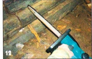
**С помощью цепной электропилы сделали прорези в брёвнах сруба в местах установки половых лаг.**
