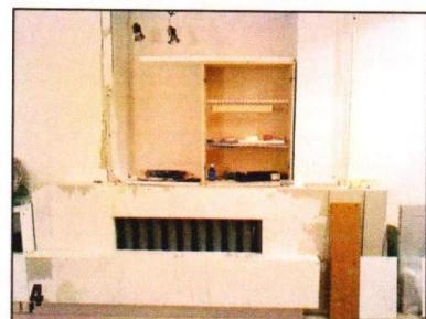
На предварительно загрунтованные поверхности гипсокартонной обшивки аккуратно наносили тонким слоем шпатлёвку и тщательно её разравнивали.
