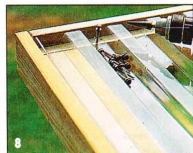
**Крепёжные отверстия в листовом пластике лучше всего сверлить коническим или ступенчатым сверлом.**
