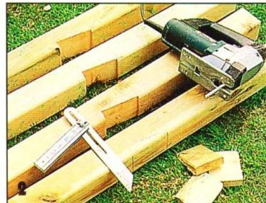
Учитывая угол наклона крыши, в стропилах с помощью электротролобзика на скос выбирают пазы под балки.
