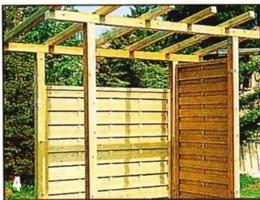
**Одну из боковых стен строения тоже зашивают досками, так как стоянка имеет ограждение с трёх сторон.**
