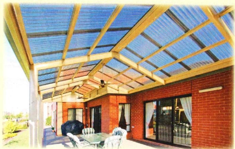
С августа 2011 г. группа компаний «Металл Профиль» начала поставки на рынок профилированного прозрачного поликарбонатного листа МП-20. Новинка может использоваться в строительстве в качестве светопрозрачных вставок в кровле и стенах.
