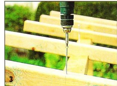
Уложенные стропила крепят сверху длинными шурупами к балкам.
