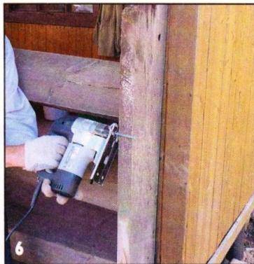
С помощью электролобзика отпилили сгнившую часть тетивы по линии, параллельной её нижней кромке.
