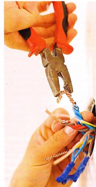
поскольку не требуют дополнительной арматуры и производить их не сложно, а кроме того скручивать жилы проводов необходимо при использовании пайки и некоторых других способах соединения, о которых речь будет идти ниже.
