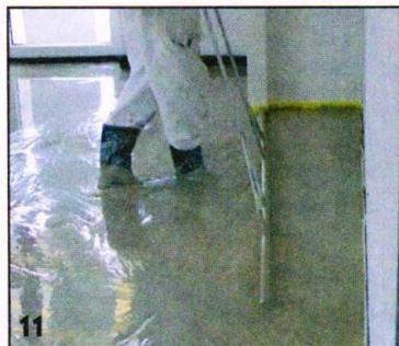
по поверхности залитой стяжки, обеспечивая более быстрое и равномерное распределение раствора и удаление из него пузырьков воздуха. После окончания заливки надо снять все реперы и ещё раз поработать металлической рейкой.
