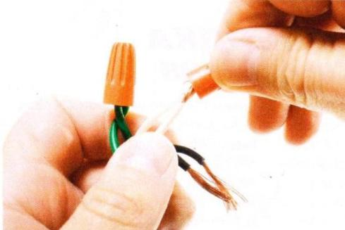
**Соединение проводов при помощи колпачка.**
