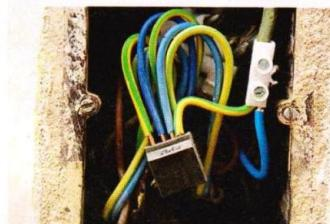
Соединения проводов при помощи клемм и клеммных колодок.
