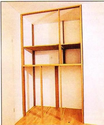
**Усиленные боковые элементы (две соединённые между собой полосы, выкроенные из плиты МДФ толщиной 19 мм) каркаса задают ширину направляющих планок для выдвижных (на роликах) контейнеров. Направляющие планки крепят к полу шурупами. Фасадный щиток каждого контейнера по всему периметру выступает на 8 мм за пределы его корпуса. Эти выступы изящно укрывают детали каркаса встроенного шкафа.**
