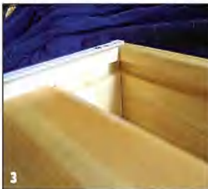
3 Для крепления дна ящика в боковых и передней стенках выбирал пазы, а у дна по трём соответствующим сторонам — четверти.
