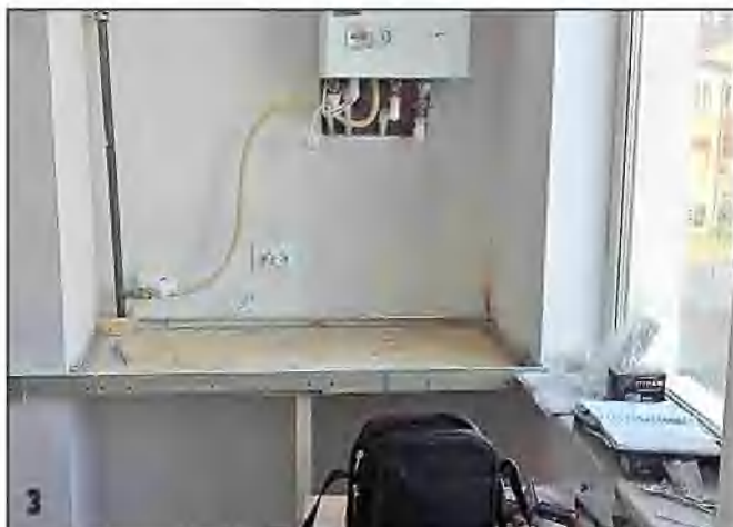
Переднюю стенку опалубки сделал из полос гипсокартона.
