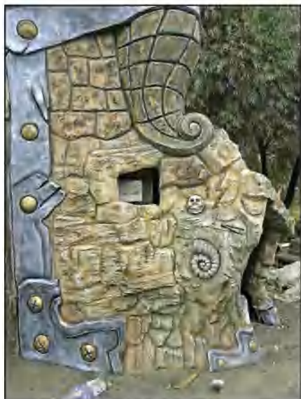
Домики для электрощитка и резервной электростанции.
