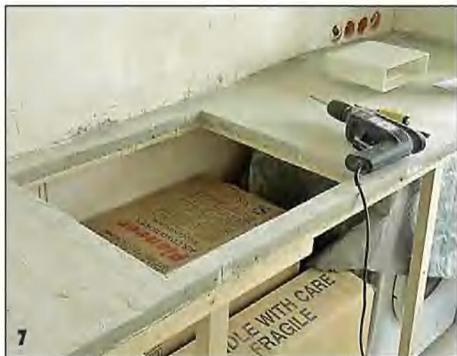
7 В местах расположения раковины и варочной панели удалил пенопласт и лобзиком вырезал в ОСП соответствующие проёмы.
