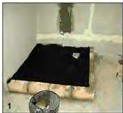
Поддон огородил кирпичом на ребро, пол внутри него заизолировал битумной мастикой.
