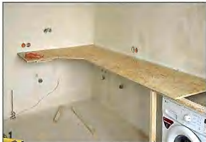
Вырезанное из ОСП основание для отливки столешницы вставил в металлический профиль, закреплённый на стене.
