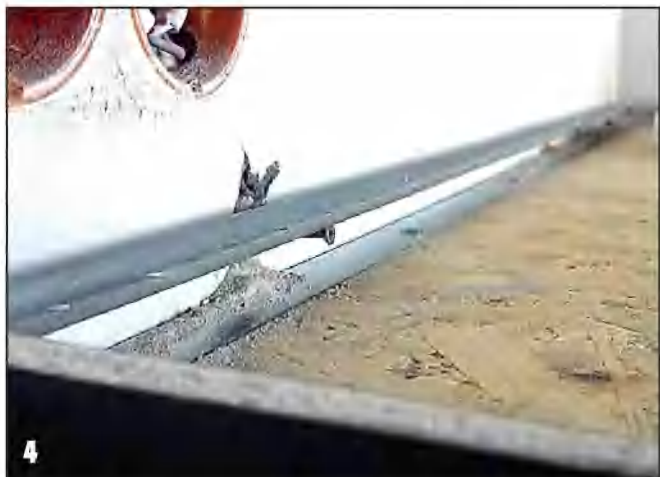
На стене закрепил стальной уголкового профиль в качестве направляющего маяка.
