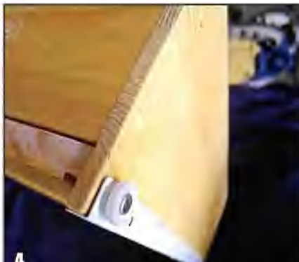
4 Ящики выдвигаются на роликовых направляющих.
