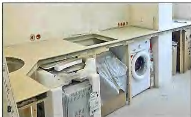
8 Плитку укладывал без швов. Передние кромки плиток срезаны под углом 45° для плотного соединения с кромочными накладками, тоже выкроенными из плиток.
