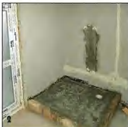
По гидроизоляции уложил утеплитель и залил сверху бетоном.
