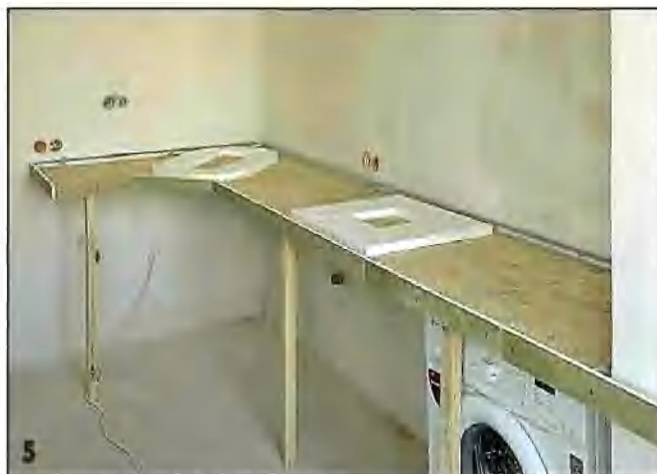
Места установки раковины и варочной панели обозначил пенопластовыми вставками.
