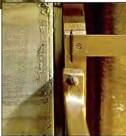
Днище ящика утоплено в четвертях, выбранных по краям стенок, надёжно прибито, вклеено и прошпатлёвано. Чтoб на века!
