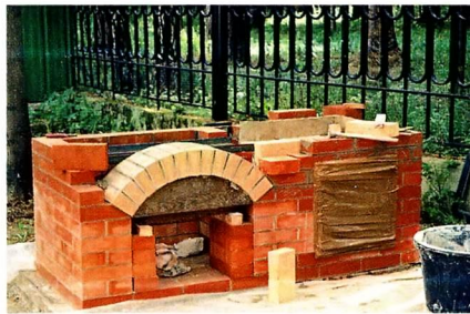
Отверстие дровника перекрыто арочной перемычкой, выложенной по шаблону.
