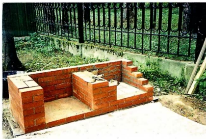
Под мангал залив фундамент, по которому под кирпичную кладку положен рубероид для гидроизоляции.
