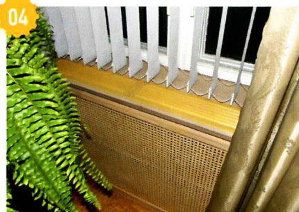
04 Экран батареи отопления и подоконник с решётками для лучшей циркуляции тёплого воздуха.
