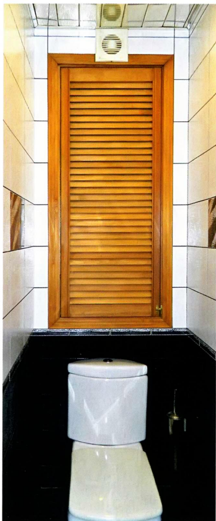
Вентилятор с задержкой отключения был установлен в вентиляционный канал.
