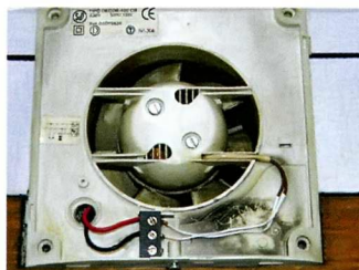
Вентилятор подключён параллельно осветительным лампам.
