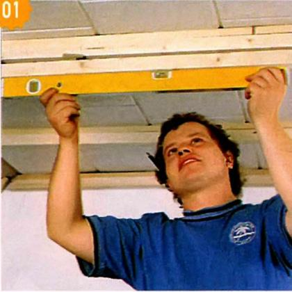
Сначала удаляют старую обшивку, прикрепляют к обрешётке дополнительные рейки и выставляют их по горизонтали с помощью подкладок и проверяя по уровню.
