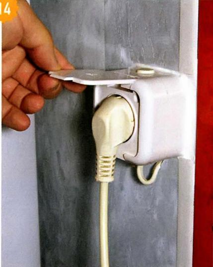
**14** Теперь остаётся вставить вилку стиральной машины в розетку, включить автомат в распределительном щитке, затем УЗО, и...
