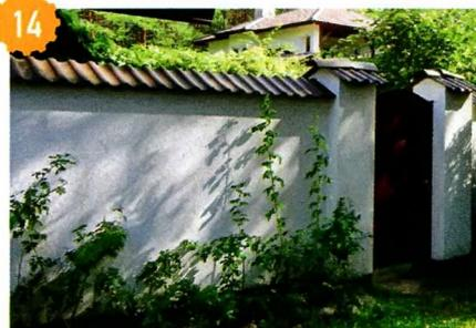
14 Оштукатуривание забора из газобетона по стеклосетке.
