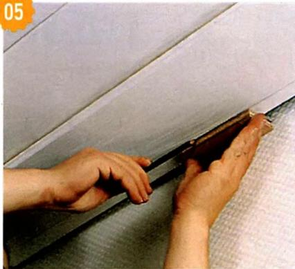
Последнюю панель подгоняют к контуру наклонной стены. Для этого, временно закрепив панель, размечают линию реза с использованием вымеренного бруска.
