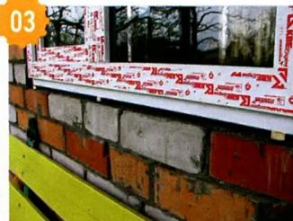
Установил окно в проём и при помощи трёх деревянных брусков выровнял его по вертикали и горизонтали. Затем брусками закрепил окно с боков и сверху.
