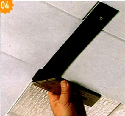
Панели в смежных рядах укладывают со смещением стыков. При этом стыки панелей как в чётных, так и в нечётных рядах должны находиться на одной линии, что можно проверить по угольнику.
