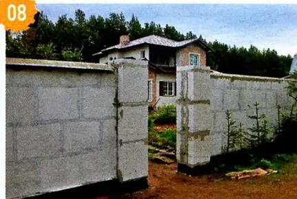
08 Готовые столбы для калитки и загрунтованная в два слоя газобетонная кладка.
