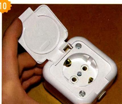
**10** Затем устанавливаем розетку. Здесь нужна защищённая от влаги розетка с крышкой и уплотнительными прокладками.
