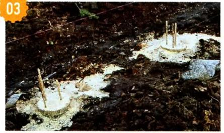
03 Бетонная смесь, уложенная в несъёмную опалубку буровых свай.
