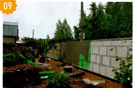
09 Оштукатуривание забора из газобетона по стеклосетке.
