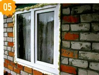
После этого запенил зазор между стеной и рамой окна. Точно так же установил второе окно.
