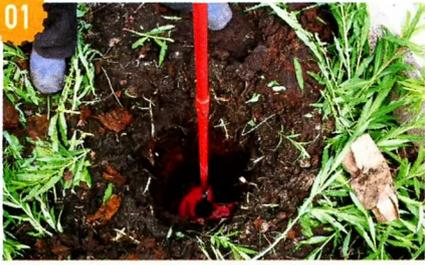
01 Ручное бурение шурфов для буровых железобетонных свай забора.
