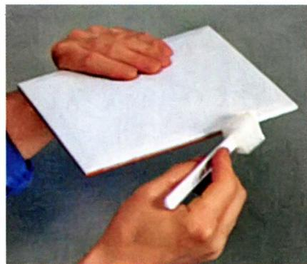
Если кромка плитки, которую планируется использовать для облицовки проступи, не глазурована, перед укладкой её можно покрыть специальной краской для керамики под основной цвет плитки.
