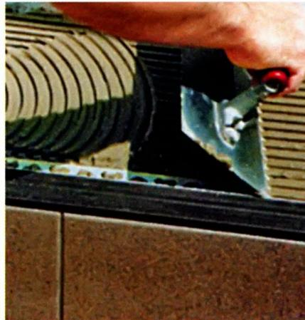
Металлическая основа защитного профиля укладывается в слой плиточного клея.
