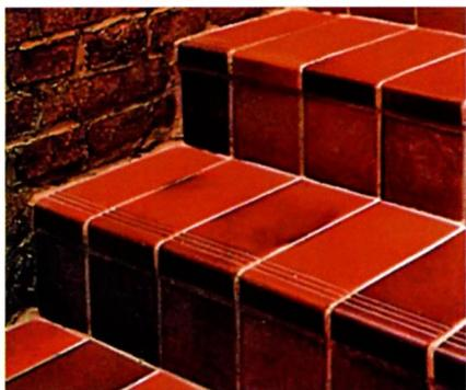
Плитки с рифлёным краем. Плитки уложены на ступени наружной лестницы.
