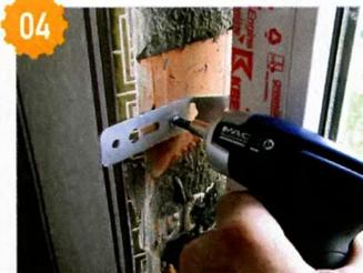
Монтажные пластины выгнул для лучшего прилегания к стенам и саморезами прикрепил их к кирпичной кладке.
