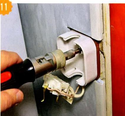
**11** Розетку устанавливаем непосредственно в месте входа кабеля в ванную комнату. Крепим корпус розетки к стене.
