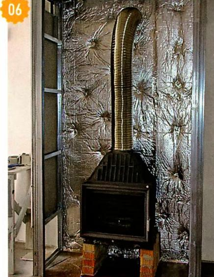
Изнутри каркас обложен фольгированными плитами Firerock.
