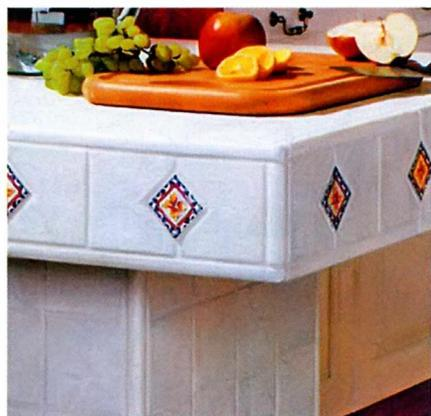
При отделке этой столешницы использованы угловые и кромочные керамические элементы. Отделку дополняют декоративные вставки.
