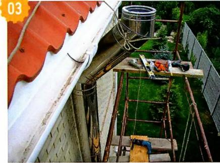
Чтобы не прорезать свес крыши, его пришлось обойти.
