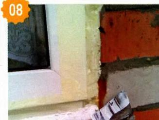
Срезал лишнюю пену с обеих сторон окна. Со стороны улицы покрыл срез герметиком для защиты от ультрафиолета и влаги.
