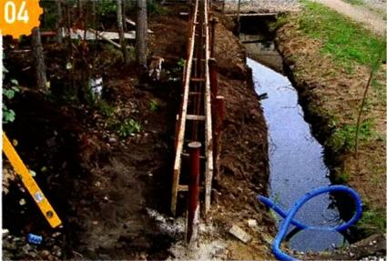
04 Подготовленный арматурный каркас и опалубка для укладки бетонной смеси для ростверка.
