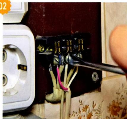
02. Отвод представляет собой небольшой отрезок алюминиевого трёхжильного провода сечением  $2,5 \text{ мм}^2$ . Подсоединяем его к клеммам розетки...
