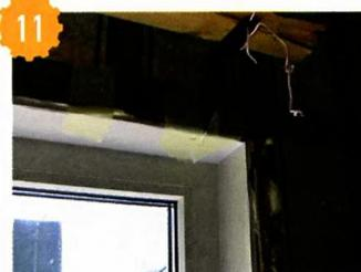
Затем установил верхний откос, подогнав его длину до боковых панелей, чтобы не было зазора. Временно закрепил его малярным скотчем. После всех приготовлений запенил вертикальные и горизонтальные зазоры.
