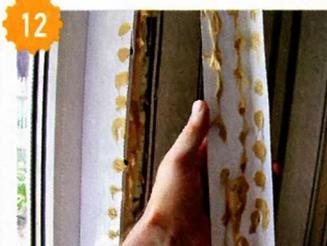
В последнюю очередь сделал обрамление откосов уголком из ПВХ, который приклеил на жидкие гвозди.
