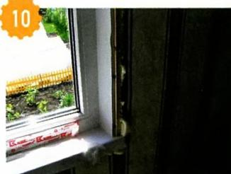
У панели тщательно подогнал нижний конец, чтобы не было зазора между ним и подоконником. Внешний край панели прикрепил к деревянной планке саморезами.
