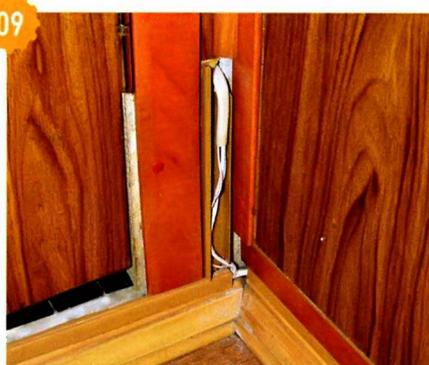
**09** Через сквозное отверстие в стене заводим кабель в ванную комнату.
