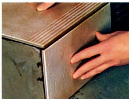
Плитку с рифлёным краем укладывают на проступь со свесом, равным толщине плитки подступёнка.
