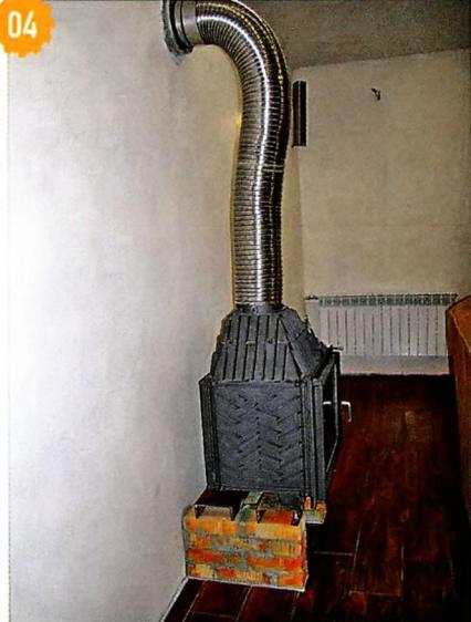
Чугунная вставка установлена и подключена к дымоходу.
