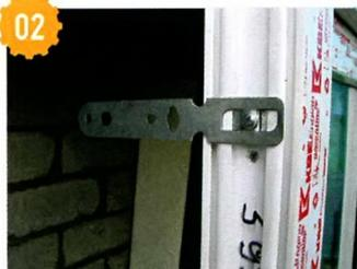
На раму окна привинтил саморезами монтажные пластины — по три с каждой стороны и две сверху. Итого на одно окно понадобилось 8 пластин.
