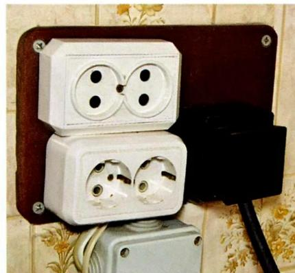
Кабель, идущий к машине, допустимо подключить к розетке электроплиты.
