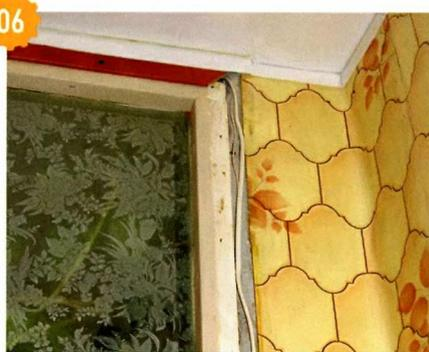
**06** Межкомнатную дверь обогнуть тоже не сложно: просто заводим провод под наличник, в зазор между стеной и дверной коробкой.
