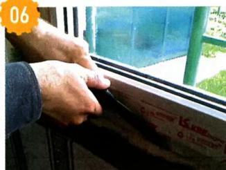
На следующий день стал устанавливать подоконники. Для этого подрезал пену в нижней части окна с внутренней стороны.
