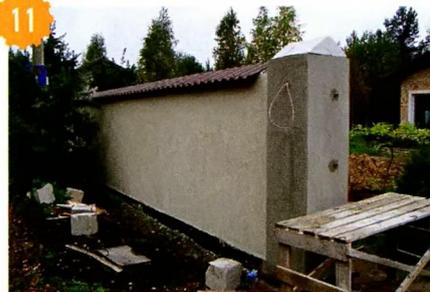
11 Укладка черепицы поверх газобетонного забора. На столбах для укладки черепицы были выложены опиленные блоки газобетона.
