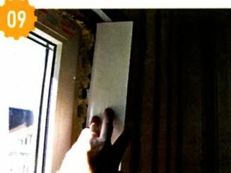
Для откосов я использовал стандартную панель ПВХ белого цвета. Начал с установки боковых панелей. Для этого подрезал пену вдоль окна, чтобы в этот паз вошла панель. А на передний край кладки проёма прикрепил саморезами деревянную планку.
