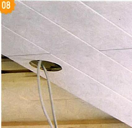
Сначала в панели сверлят отверстие под пилку электролобзика, а затем выпиливают в ней отверстие под корпус светильника. Прежде чем монтировать светильник, прокладывают кабели.
