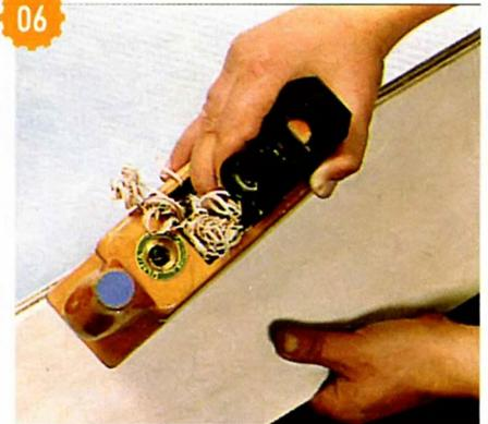
Наружную кромку последней панели, выкроенной по ширине электролобзиком, обрабатывают рубанком на скос. После этого панель аккуратно вставляют на место и прибивают гвоздями.
