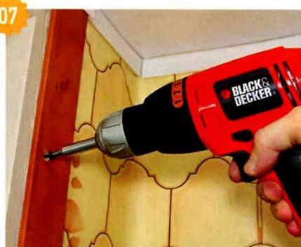
**07** При установке наличника внимательно следим, чтобы не передавить кабель и не повредить его саморезами.
