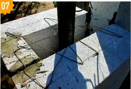
07 В качестве несъёмной опалубки при устройстве столбов для калитки и ворот использовали кладку из блоков.
