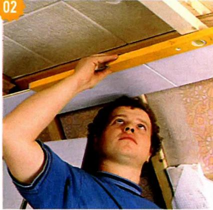
Кромку панелей первого ряда, обращённую к наклонной стене, обрабатывают рубанком на скос. Затем панели крепят снизу отделочными гвоздями непосредственно к рейкам обрешётки. Лунки поверх шляпок гвоздей заделывают древесной шпатлёвкой.
