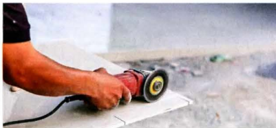
При резке керамогранита можно использовать небольшую болгарку с алмазным диском.
