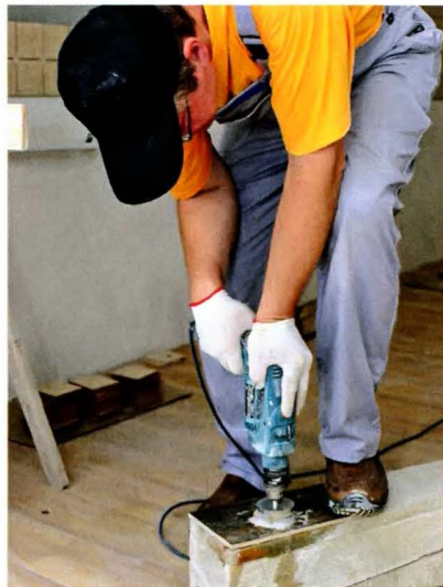
Сделать отверстие большого диаметра в керамической плитке можно с помощью дрели с алмазной коронкой.
