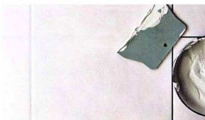
Заделывать швы между плитками удобнее всего резиновым шпателем.
