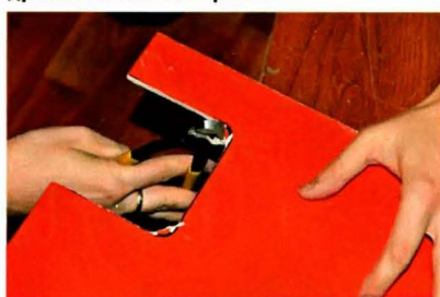
Кусачки пригодятся при скруглении углов выборки в плитке.
