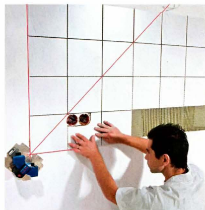
Проецируемые лазерным угольником линии хорошо помогают при разметке и контроле правильности укладки плитки.
