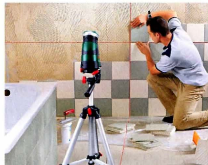
Работа с использованием лазерного уровня будет производительнее и качественнее, чем при использовании традиционного отвеса или пузырькового уровня.
