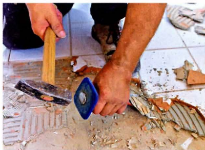
Подготовка основания — снятие старого плиточного покрытия.
