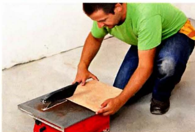
Хорошего результата при раскрое плитки можно добиться при использовании электрического плиткореза.
