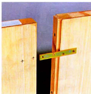
Фанерные щиты соединяем металлическими накладками.
