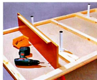
Устанавливаем полку, крепим её шурупами на брус. Скалки для плечиков закреплены на брус шурупами.
