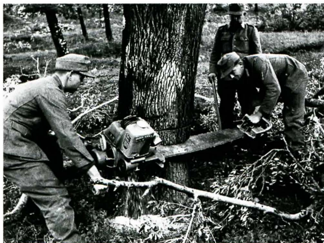
А в 1927 году Эмил Лерп представил широкой публике первую в мире пилу с бензиновым двигателем. Бензиновый двигатель внутреннего сгорания обеспечил автономность и мобильность инструмента, однако размер его всё равно был довольно крупным, вес машин составлял примерно 50 килограммов.
