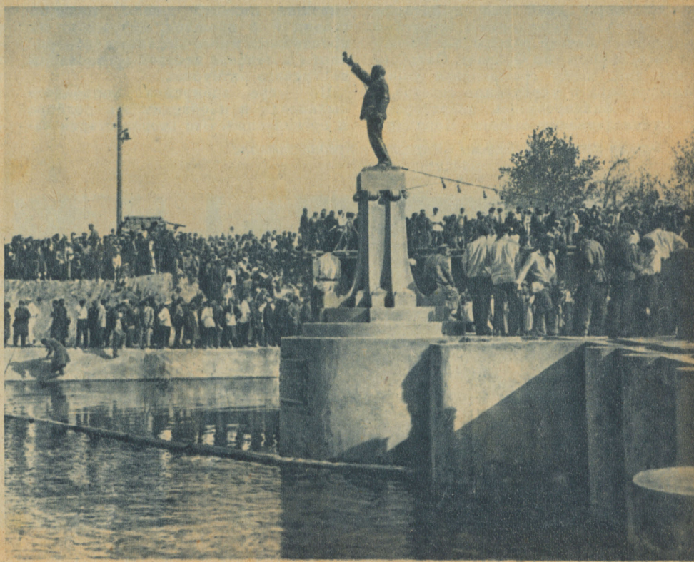
Открытие электростанции на реке Боз-Су. Из хроники Узбеккино. Оператор Ф. Назаров
