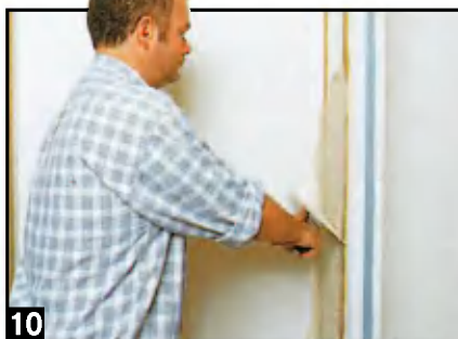
Опорные рейки служат ограничителями толщины слоя штукатурки, наносимого шпателем. После высыхания штукатурки рейки очищают тряпочкой.
