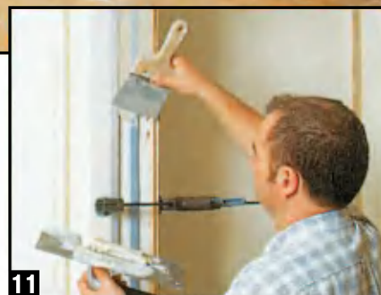
Чтобы получить ровный слой штукатурки на фасадной стороне верхних опор, струбцинами прижимают пару реек, выступающих на 8 мм (толщина раскладки).
