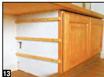
Направляющие выдвижных ящиков с помощью дюбелей для пористых материалов и шурупов крепят на внутренних поверхностях пенобетонных опор цоколя.
