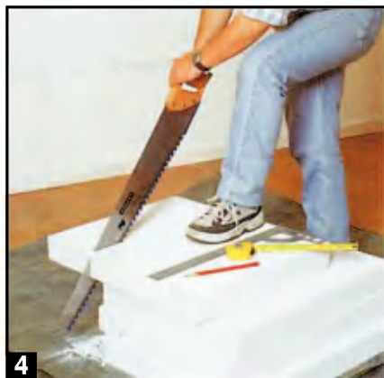
4 Раскрой пенобетонных блоков ведут ножовкой с крупными зубьями. Неровности на кромках можно удалить рашпилем или обычным рубанком.
