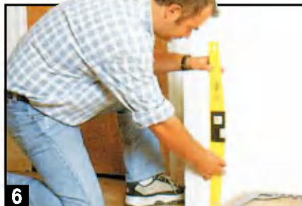
6 При монтаже пенобетонных блоков следует постоянно контролировать их положение с помощью строительного уровня, особенно в помещении с недостаточно ровными стенами.
