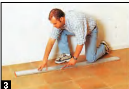
3 Для разметки положения цоколя требуется длинное правило и большой угольник. Линии положения на пол можно нанести фломастером или специальным карандашом.
