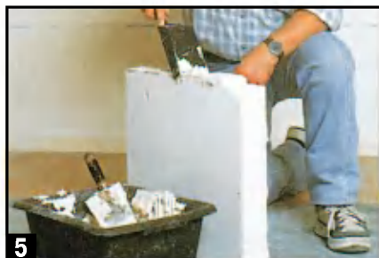
5 Специальный клей для пенобетона приготавливают в необходимом количестве с учетом того, что его надо использовать в течение часа. Наносят состав зубчатым шпателем.
