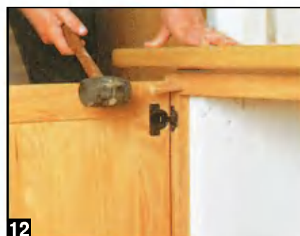
Дверные блоки крепят к пенобетону круглыми деревянными пробками, плотно забитыми в отверстия на клею, которые срезают заподлицо после его высыхания.
