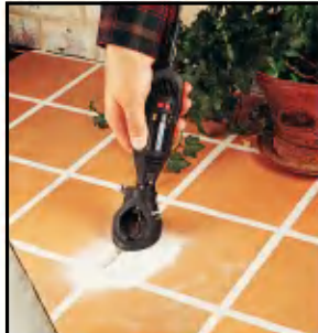
Удаление треснувшей плитки
