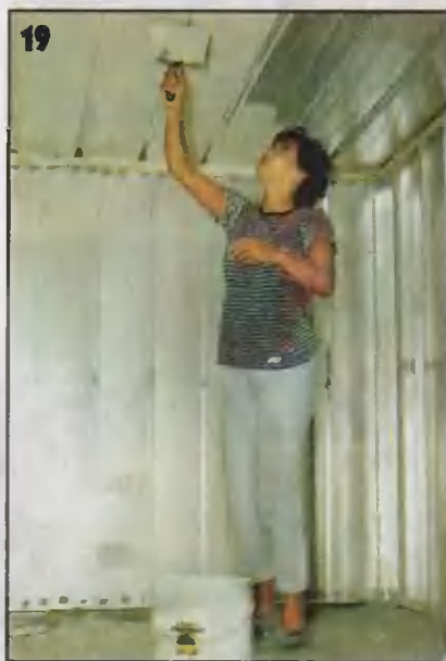
На потолок кистью наносят специальное покрытие, препятствующее образованию конденсата.
