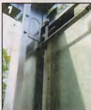
Боковая стена должна входить в раму ворот ровно на 5 см.
