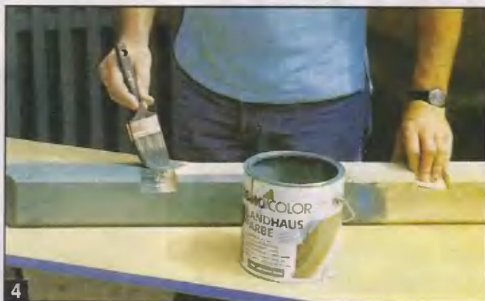
4 Столбы для забора пропитывают консервирующим раствором. Перед установкой в ямы их окрашивают масляной краской, обеспечивая дереву дополнительную защиту. Забор можно красить в самые необычные цвета, предварительно перемешивая краски.
