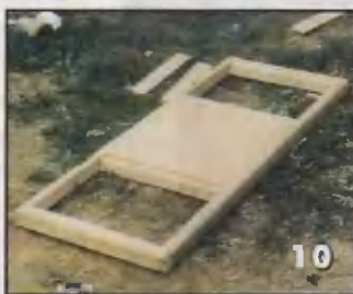
Один из вариантов обшивки двери — сочетание горизонтального и вертикального расположения досок. Работу начинаем с набивки окантовочных реек по периметру каркаса.
