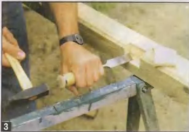
3 Уложив на козлы, столб надежно закрепляют. Для этого подойдут любые столярные струбцины. Промежутки между пропилами вырубает стамеской. Хорошо наточенный инструмент облегчает работу.
