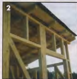
Завершен очередной этап работ — основа каркаса смонтирована, один слой рубероида защитит конструкцию от непогоды.
