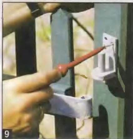
9 Навесы петель с осью привинчивают шурупами к столбу ворот на нужной высоте. При этом следят, чтобы не было перекоса петли.
