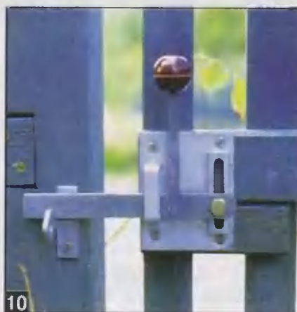
10 Звпор со щеколдой и «собачкой» прикрепляют в зависимости от того, в какую сторону будут открываться ворота.
