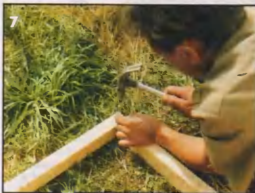
Угловое шиповое соединение скрепляем гвоздями.
