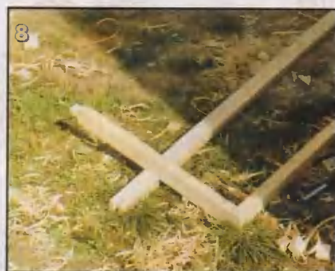
Аналогично соединяем все углы рамы обвязки.
