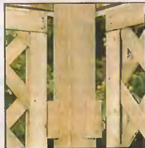
Решетчатые элементы крепят к стойкам, раме пола и карнизным доскам с помощью отрезков деревянных брусков.
