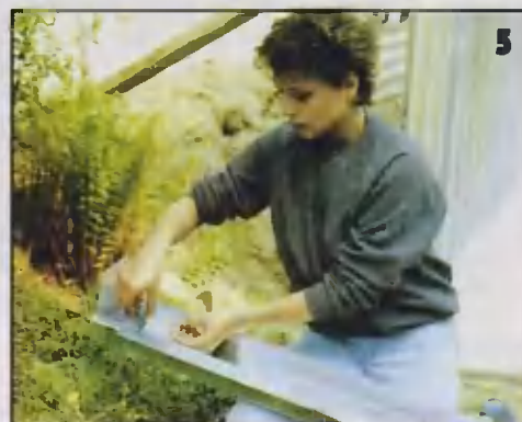
Теперь раму ворот наводят на боковые стены и крепят болтами. Для проверки прямоугольности гаража измеряют диагонали. Если они одинаковой длины, гараж собран правильно.
