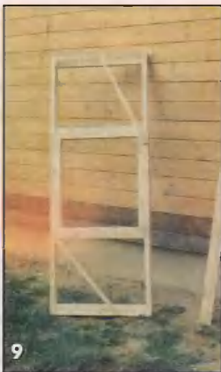
Завершаем изготовление каркаса дачи установкой дополнительных элементов, которые придают конструкции жесткость и облегчают обшивку дачи. После контроля прямоугольности каркаса скрепляем его временными стяжками.
