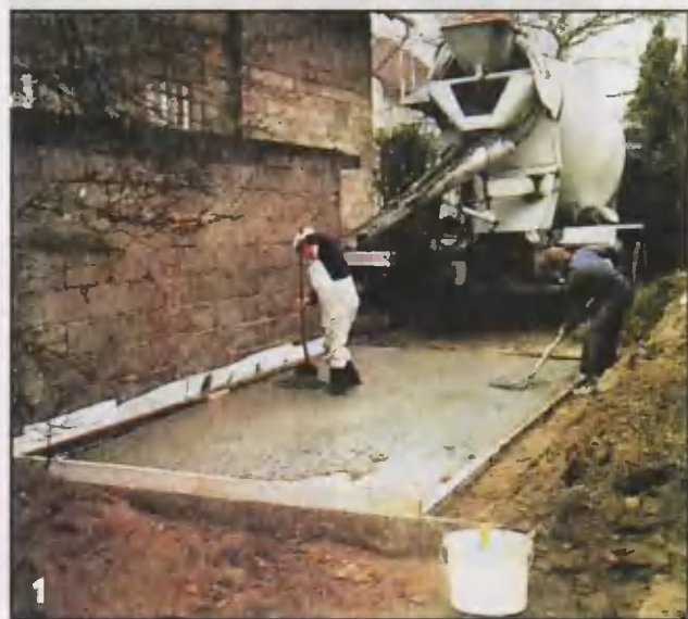
Фундаментом гаража служит отлитая из бетонного раствора плита, армированная проволочной сеткой. Толщина плиты — 10 см.
