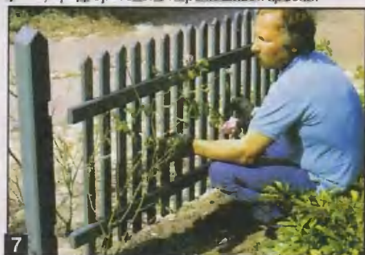
7 Пролеты забора также красят масляной краской до их установки. Когда краска высохнет, просто вставляют пролеты в пазы столбов и крепят шурупами. Предварительно в прожилках сверлят и раззенкуют отверстия под шурупы.
