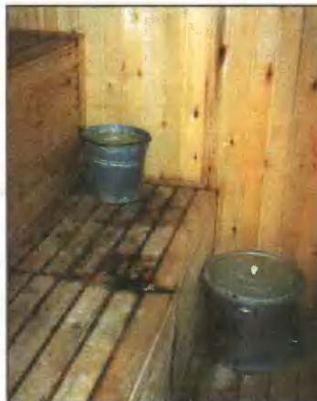
Полки наглухо зашиты шпунтованными досками (вагонкой) без каких-либо зазоров. Под ними нет пола и обшивки стен. Там, куда попадала вода, видны следы гниения древесины. Половые лаги уложены без гидроизоляции. И отсутствовали продухи для вентиляции подпольного пространства.
