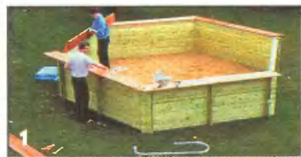
Дощатые щиты каркаса бассейна собирают на подготовленной площадке.
