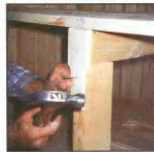
Настил полков — из осиновых досок, а стойки и ригели — из сосновых брусков.
