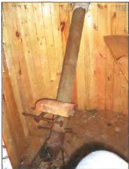
Три в одном. Печь, топливник и дымоход — в одной трубе.
