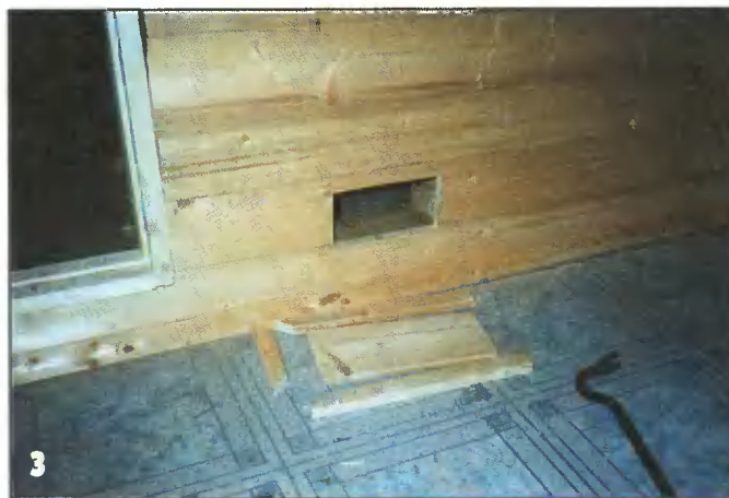
Устройство стенки переборки сауны.
