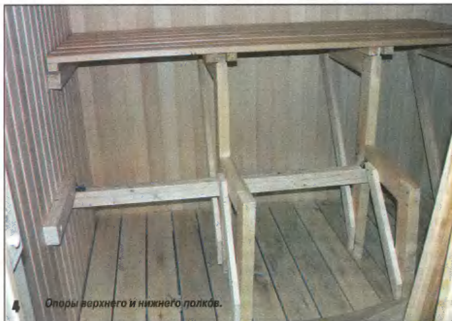
Приставная скамейка имеет простейшую конструкцию. Высота её — 200 мм.
