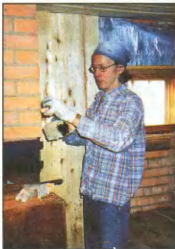
Чтобы демонтировать печь, надо было разобрать сначала дымовую трубу.
