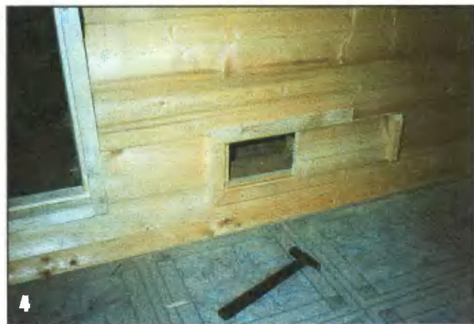
Задвижка входного воздушного отверстия.
