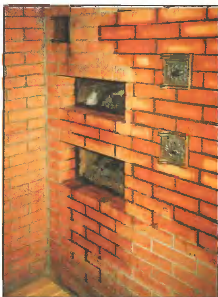
Печь конструкции С.Волкова с нишами для каменной засыпки. Камни располагаются на чугунных плитах.
