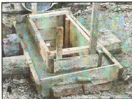
Бетонирование стенок приямка.
