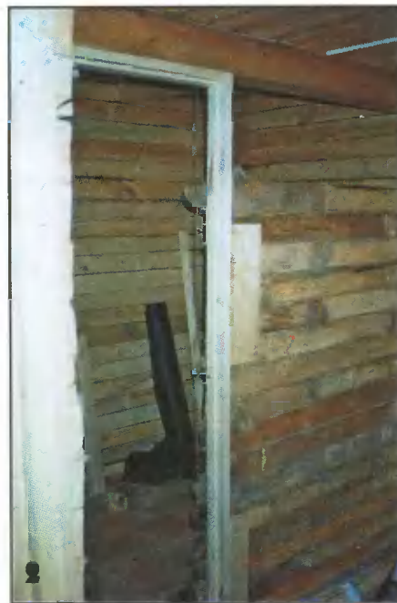
Устройство стенки переборки сауны.
