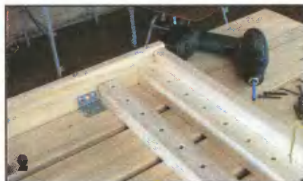
Рейки настила обоих полков соединены брусками-стяжками сечением 30х30 мм.
