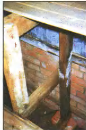
Полки наглухо зашиты шпунтованными досками (вагонкой) без каких-либо зазоров. Под ними нет пола и обшивки стен. Там, куда попадала вода, видны следы гниения древесины. Половые лаги уложены без гидроизоляции. И отсутствовали продухи для вентиляции подпольного пространства.
