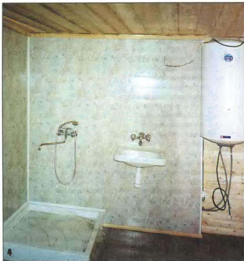
Установка пластиковых панелей, приклеенных на «жидких гвоздях», завершена. В правом верхнем углу сделан вывод электропровода для подключения бра.
