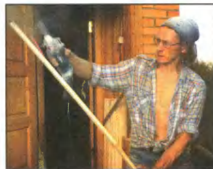
«Бэушную» вагонку отшлифовали наждачным кругом с помощью «болгарки».
