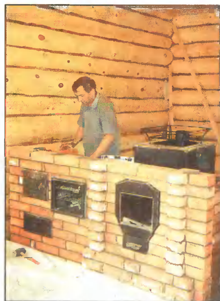
Момент строительства отопительного комплекса с металлической печью-каменкой (за работой — Н.Сердюк).
