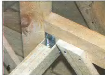
Узлы крепления опор — сборно-разборные.
