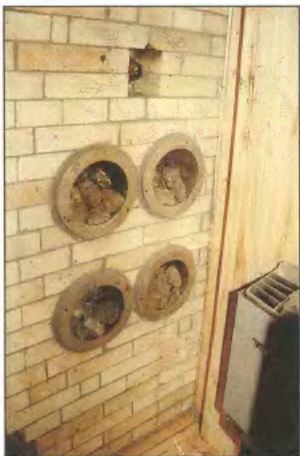
Печь-каменка с духовками в виде стальных труб \varnothing 200 мм (автор А.Заболотный).
