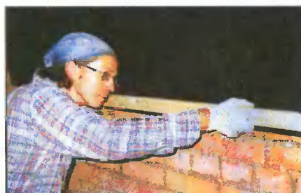
Полотна пергамина к кирпичной стене прижимали брусками.
