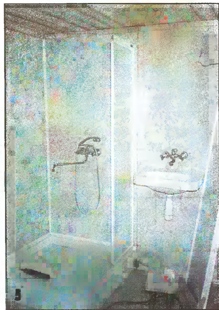
Монтаж душевой кабины я производил согласно прилагаемой к ней инструкции. Главное было — соблюсти отвесность стеновых профилей и горизонтальность телескопических полозьев. Изнутри кабины стык между поддоном и нижним профилем уплотнён прозрачным силиконовым герметиком.
