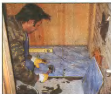
Вид на печь-каменку из душевой. Поверх деревянного пола закрепили асбестоцементный лист, который стал основанием для напольной керамической плитки.
