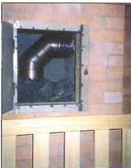
Окно каменной засыпки с дверцей.
