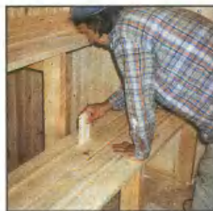
Чтобы сделать равными зазоры между досками полков, использовали обрезок доски в качестве шаблона.
