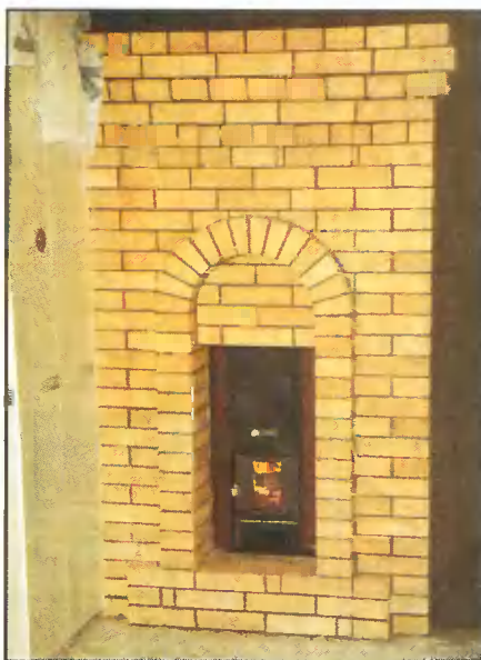
Другая разновидность металлической печи и иное оформление. Кладка — из шамотного кирпича.
