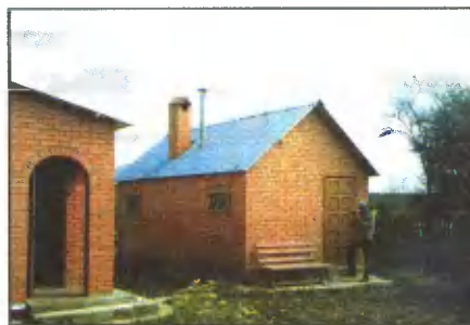
Баня представляла собой кирпичную постройку с оштукатуренным цоколем. Размеры её в плане — 3х6 м.
