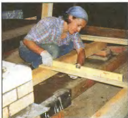
Поверхность пола сделали с уклоном в сторону, где находился слив для воды.
