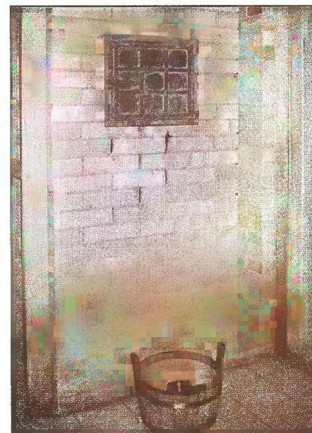
Печи с каменкой «на проход» (камни внутри печи обогреваются непосредственно дымовыми газами). Вид из парильного отделения.
