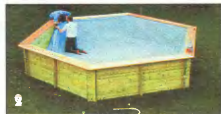
Чашу бассейна покрывают пластиковой плёнкой, края которой заделывают обрамлением бортов бассейна.
