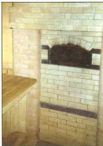
Печи с каменкой «на проход» (камни внутри печи обогреваются непосредственно дымовыми газами). Вид из парильного отделения.
