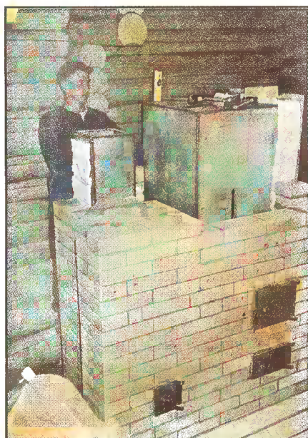
Рабочий момент кладки печи с водогрейным баком (за работой А.Гвоздев).
