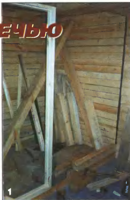
Закладка входного воздушного отверстия.
