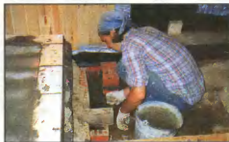
В первую очередь изготовили жёлоб для удаления воды, по которому она должна уходить наружу. На снимке виден новый фундамент банной печи, который немного больше прежнего.
