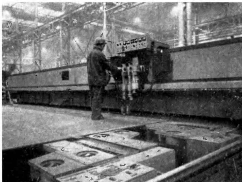
Рис. 3. Сварка полотнища автоматом «Мир» на поточной линии Выборгского судостроительного завода.
