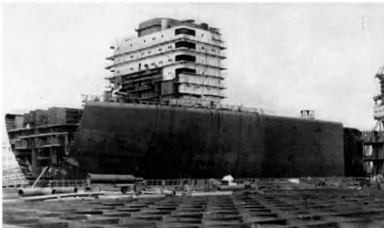
Формирование корпуса танкера «Крым» в доке.
