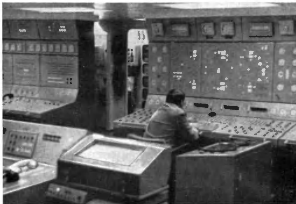
Рис. 3. В центральном посту управления ледокола «Арктика».
