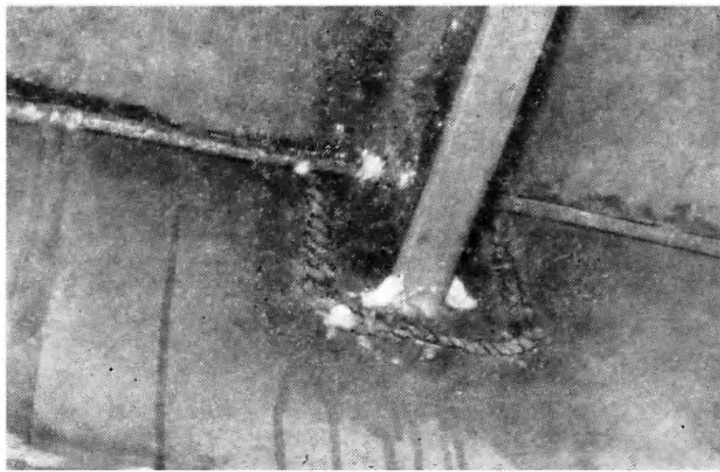
Рис. 2. Кокон пены через 4 ч после нанесения полимерного состава.
