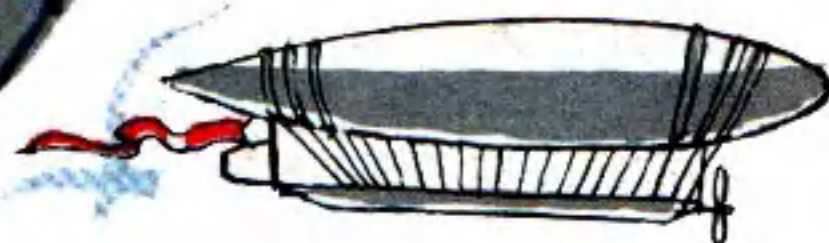
Первый управляемый аэростат, построенный во Франции. Его винт вращал человек.
